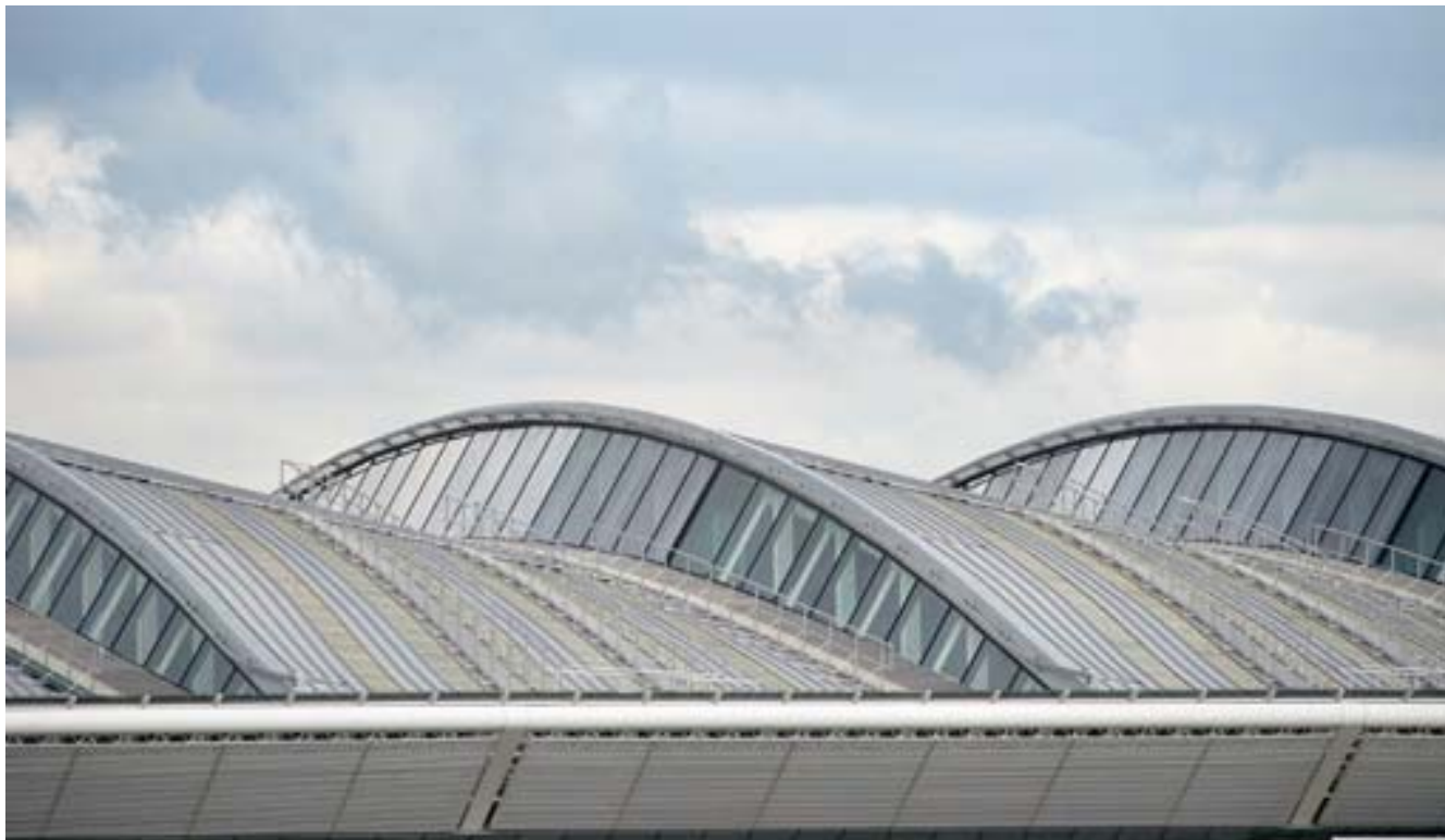
Detalle de la cubierta de la T2 de Heathrow
